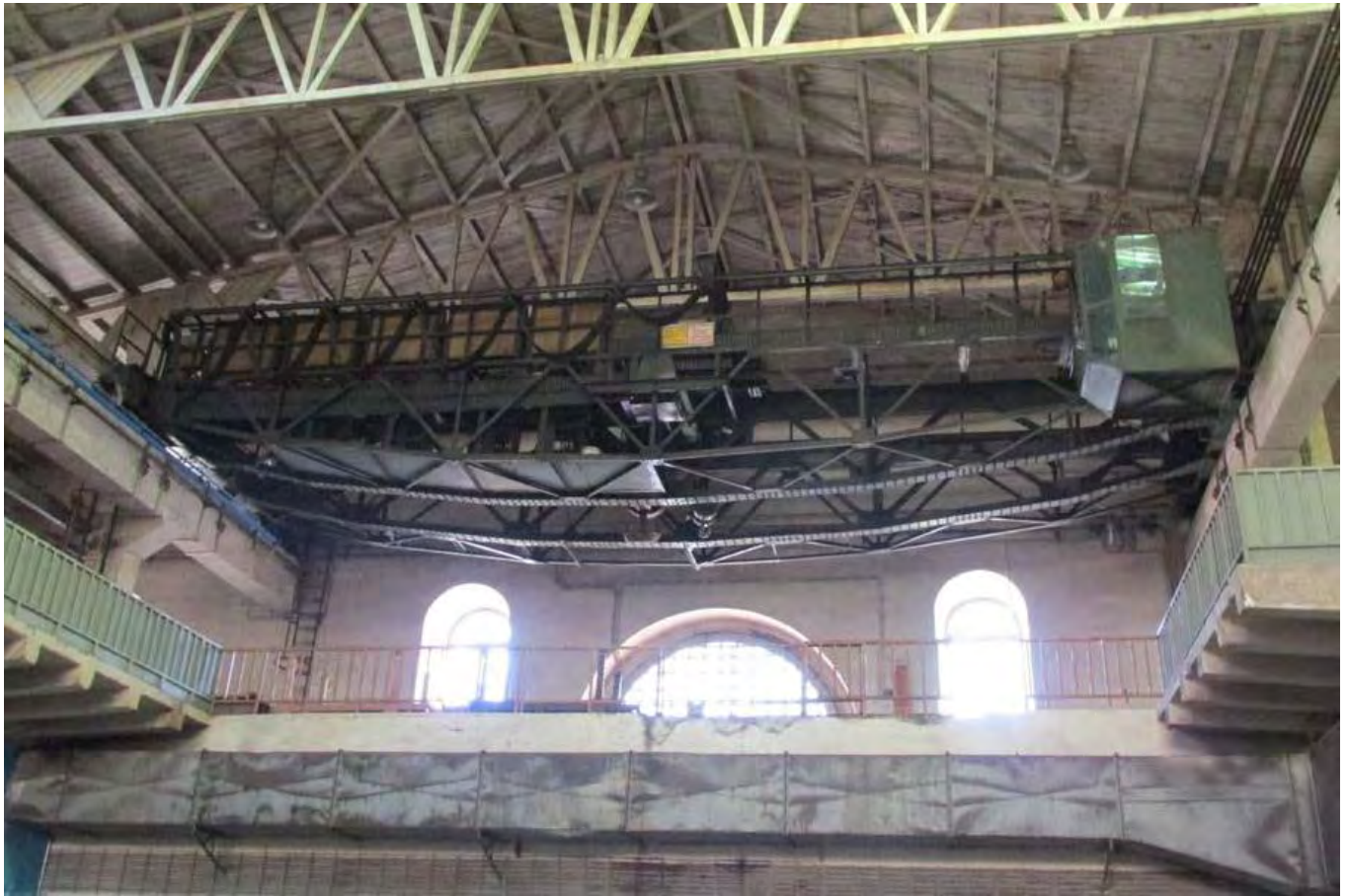
Rb.1459. blb0000954 • DVOGREDNA MOSNA DIZALICA , tip. DMD 30/6,3T / 16,858m, pr. MIN Niš
